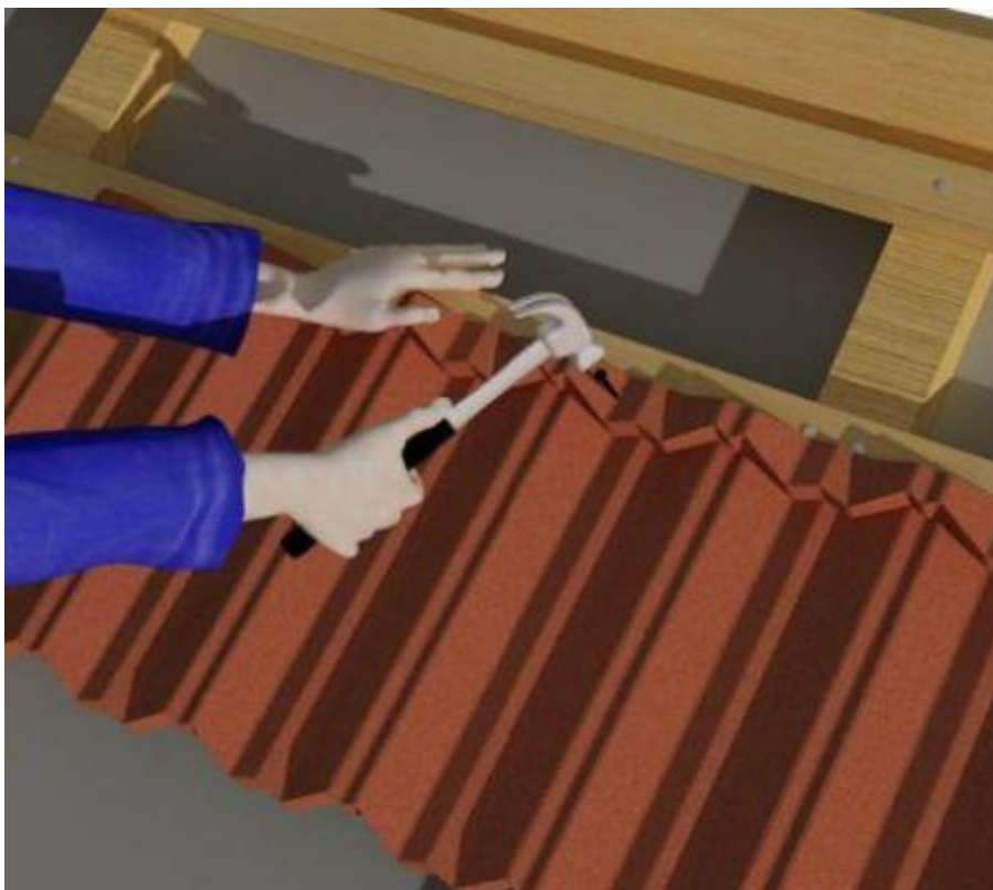
Pokládka druhé řady šablon směrem od hřebene
