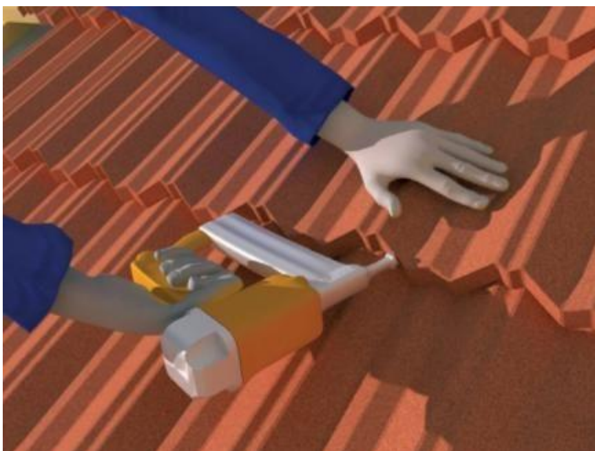
Obrázek demonstrující přibíjení šablon hřebíkovačkou
