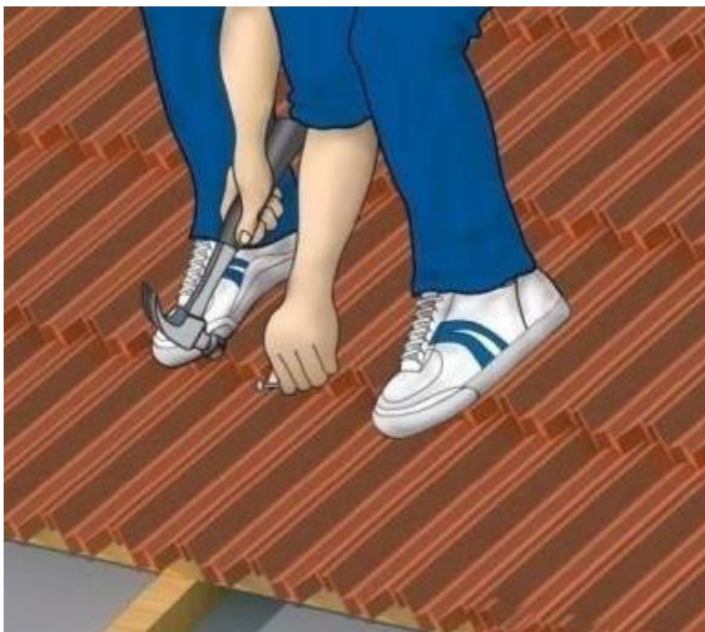
Obrázek demonstrující ruční přibíjení šablon
